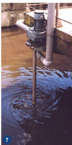
1. Agitatore trituratore montato lateralmente ( 60 m<sup>3</sup> )
