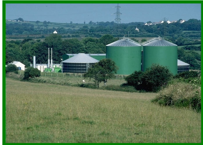
Impianti di cogenerazione da Biogas
