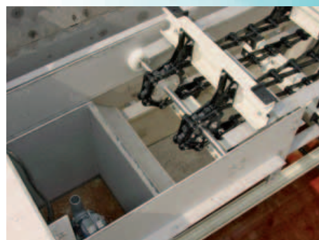
Unità a pale con funzione di raschiatore per fango flottante
