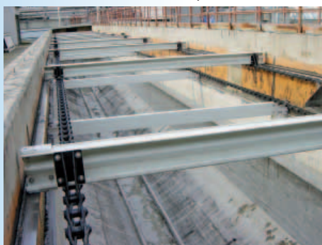
Impianto a flottazione
