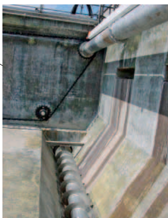
Riadattamento di impianti esistenti
